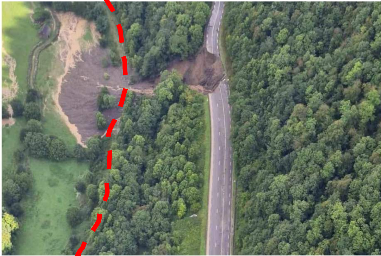
Entre Urdos et le tunnel du Somport sur la RN134, la chaussée s'est dérobée rendant la circulation impossible. (©DR)
